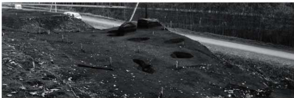
調査完了状況 1 (北西から)
