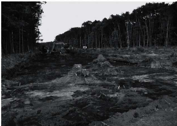
2 表土除去作業（平成25年度）
