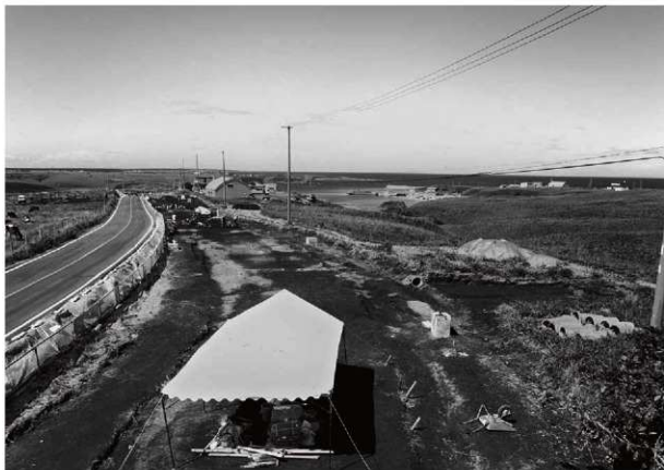
調査風景（東から）
