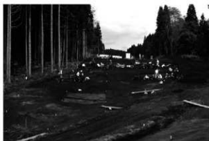
50ライン付近調査状況
