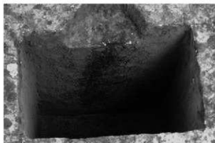
HP-2 セクション 北から
