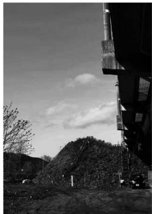
道跡近景 SW→NE
