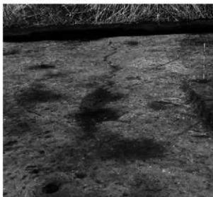
3 地割れ検出 (O51~53区)
