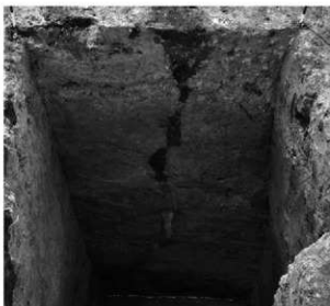
4 地割れ断面 (O52区)
