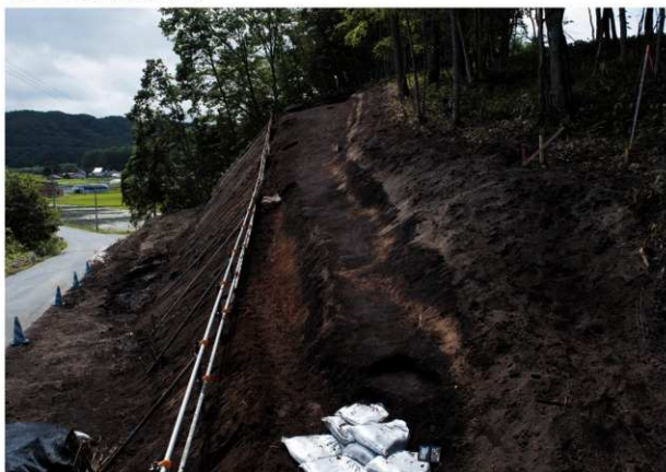
V層上面検出状況（北西から）
