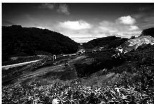
調査区南西部調査状況（南から）
