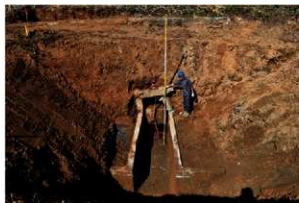
3 用水路跡「樋門」検出状況 (南から)
