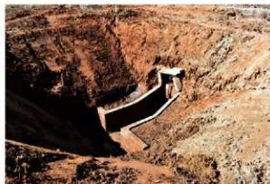
4 用水路跡「樋門」検出状況 (東から)
