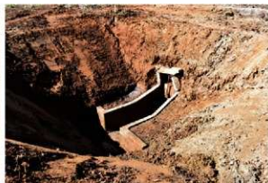
4 用水路跡「樋門」検出状況 (東から)
