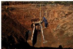
3 用水路跡「樋門」検出状況 (南から)
