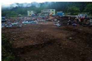
2. SQ18 北側の削平状況 (北西から)
