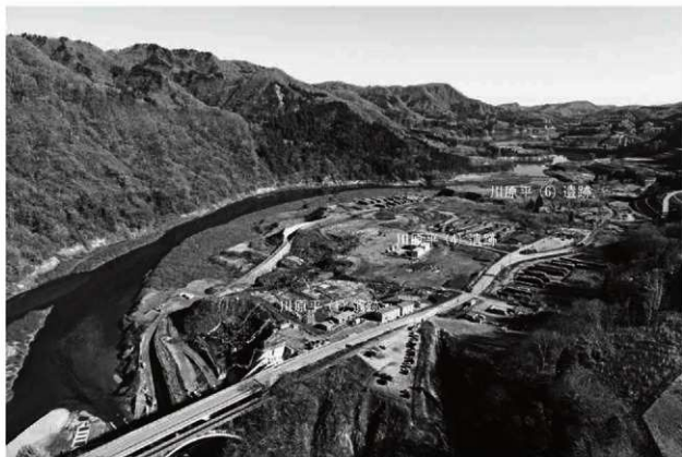
遺跡全景（南西から）
