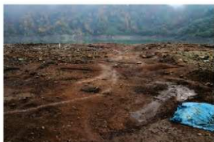
沢1 完掘状況(ⅧE-99グリッド付近から北)
