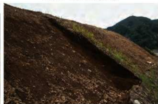
北斜面 土層B-B'(南東から)
