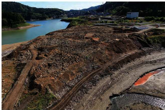
西斜面 完掘状況(西から)
