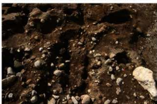
掘方完掘状況(北東から)
