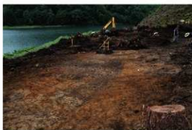
工事区域南端削平状況 IVU-21
