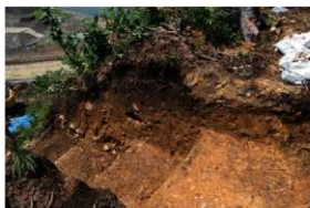
トレンチ15 南から
