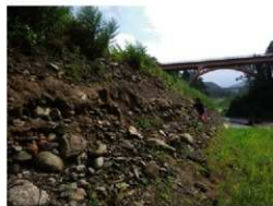
4. 仮設道路の法面で確認された段丘層 (写真提供: 新潟大学小野嶋介先生)
