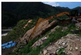
斜面のトレンチ 表土除去
