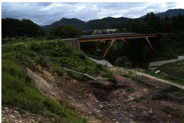
終了状況 北から
