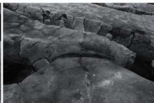
ビット 6・7 間土層堆積状況（北から）
