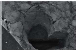
ピット8完掘状況（南西から）
