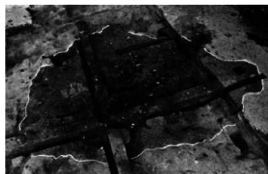
検出状況 (SW→)
