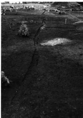
第521号溝跡完掘 S→
