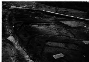
第501A号建物完掘 SE→
