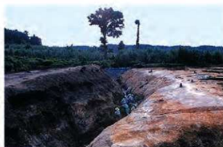
濠（南側）での作業風景
