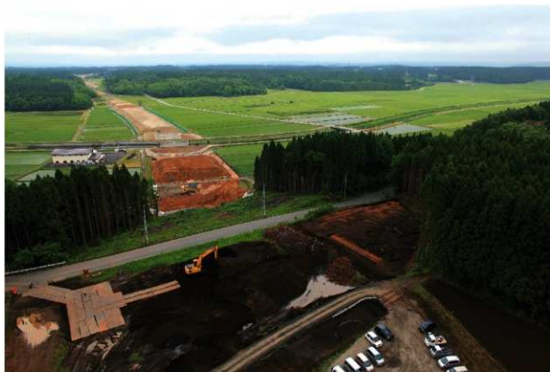
調査区近景（南東から）
