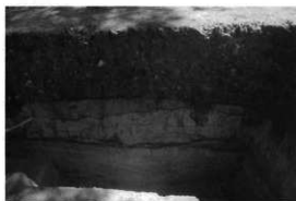
B区第1トレンチ断面
