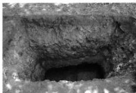
C区第4号トレンチ断面
