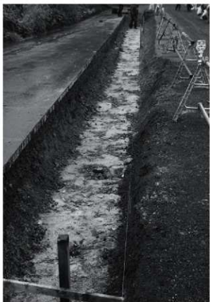
II F～II J-138～143 グリット付近完掘（北西から）
