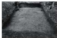
14 トレンチ 完掘 (南西から)
