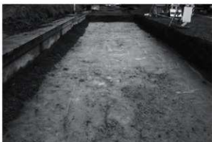
I A～I F-103～108 グリット付近完掘（北西から）
