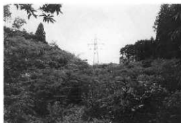
既設鉄塔（斜面向下）
