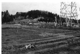
調査前の状況（南東→）
