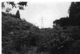
既設鉄塔（斜面下→）
