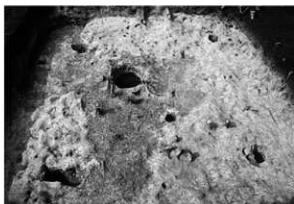
貼床除去 (南東→)
