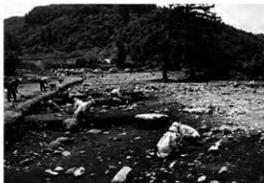
北区埋没沢作業風景
