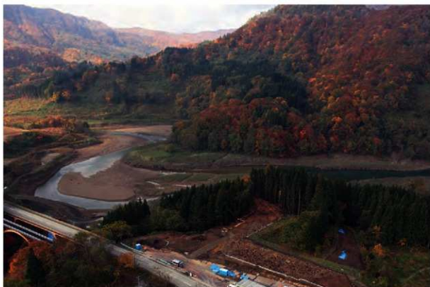
遺跡遠景 南東上空から
