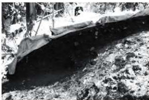
SN-B トレンチ 5 セクション W→ セクション (7)
