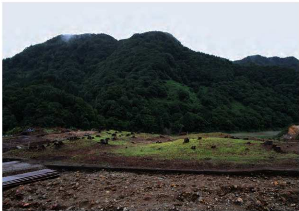
平場地区 盛土遺構全景 南→
