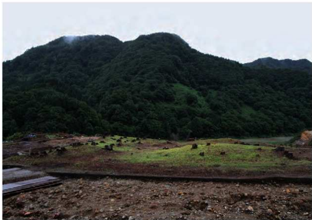
平場地区 盛土遺構全景 南→
