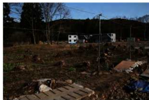
4 盛土地区 北西→
