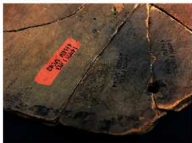
4 写真 83-1 破断面拡大
