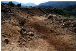
6 クラック地区完掘(1) 東→
