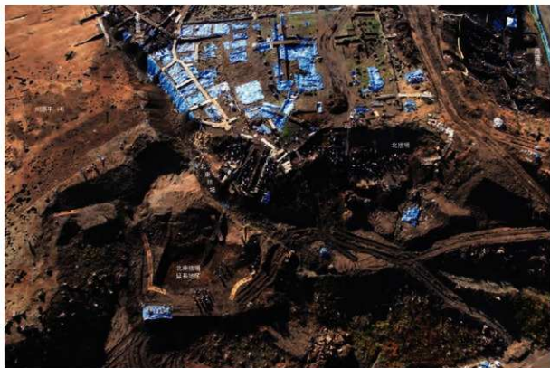
1 調査区全景 上方が南
