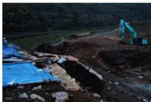
1 北東捨場延長表土除去状況 北東捨場より 南西→
