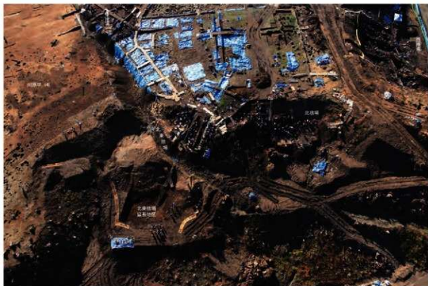
1 調査区全景 上方が南
