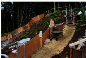
1 調査風景 作業環境 西→
