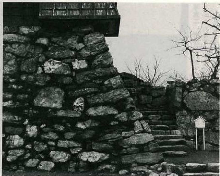
写真四 現存する天守台石垣と東付櫓の石垣（部分） 一九六〇（昭和三五）年一月に撮影されたものです。 石垣角の算木積みのようすがよくわかります。
