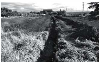
試掘調査状況 (北から)
