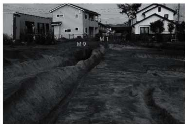
M 1号溝址 (弥生後期環濠 西から)
