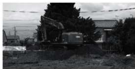
重機による表土除去作業
