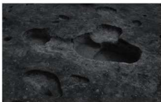
D28・D29 付近完掘状況
