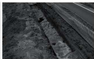
H3・H4 堀方完掘状況
