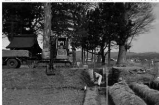
大沢前田遺跡1 掘削状況
