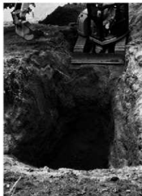
塚部分掘削状況
