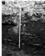
堆積状況(電気科棟)
