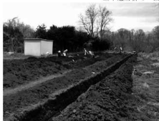
東側調査区 調査風景
