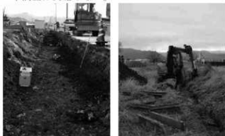
儘田遺跡2 掘削状況 御嶽遺跡3 掘削状況
