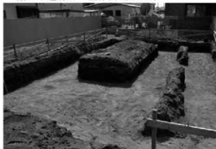
トレンチ全景
