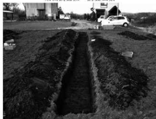
西側調査区 掘削状況
