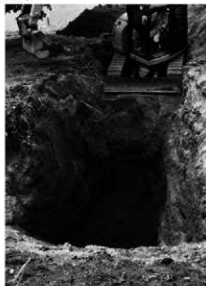
塚部分掘削状況
