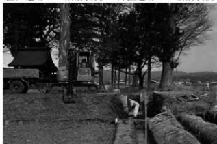
大沢前田遺跡 1 掘削状況
