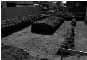
トレンチ全景
