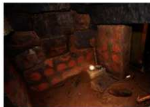
永安寺東古墳羨道部の被害の様子
