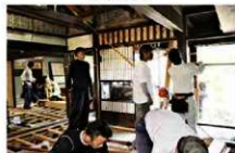
修理中の主屋
