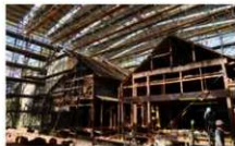
巨大な梁屋根の中で復旧中の主屋
