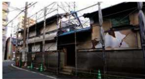
被災後の外観
