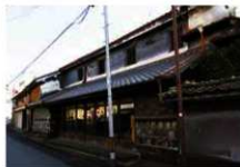
被災後の主屋（北西側）
