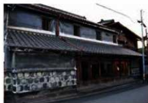
主屋外観（北東側）左下の壁が海鼠壁（被災後）
