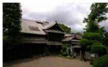
被災前の主屋 (大津町提供)
