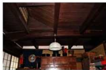
1階ミセの天井が一部開閉できる
