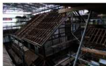
解体中の主屋
