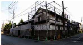
修復中の様子（北西側より）
