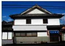
被災前の主屋（宇城市提供）
