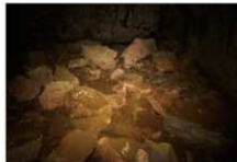
石室内被災の様子
