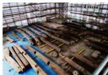
楼門解体部材
