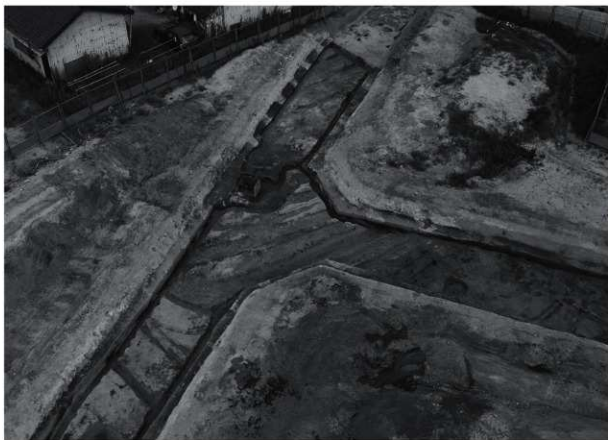
36 ST3128 全景 (南東より)
