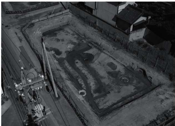
23 2工区全景（南西より）
