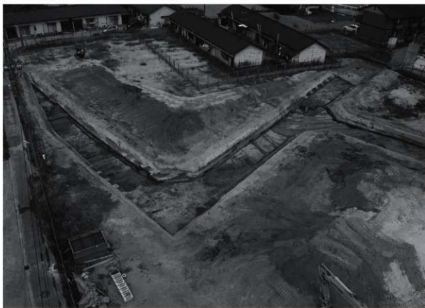
48 3工区全景②（南東より）
