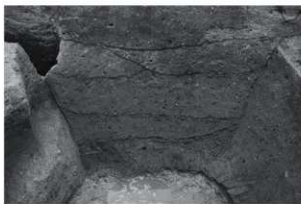
74 SD4075 断面（西より）
