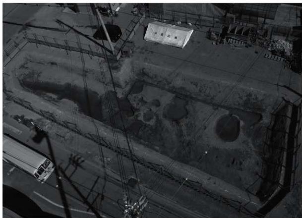
14 1 工区全景（東より）
