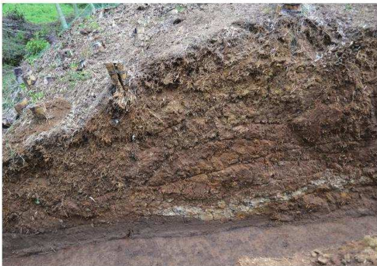
曲輪Ⅱ盛土土層断面 (B~B')
