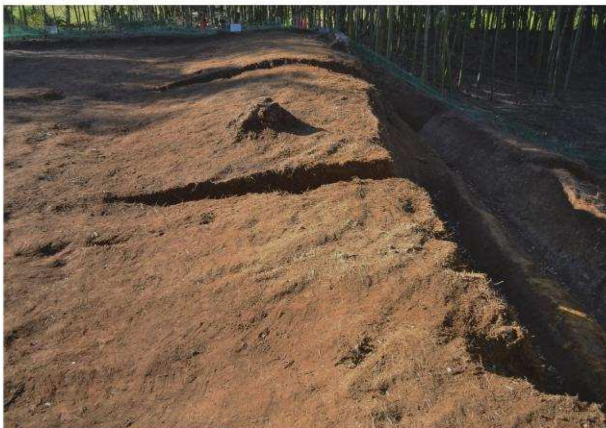
土塁表土除去後状況（北東から）
