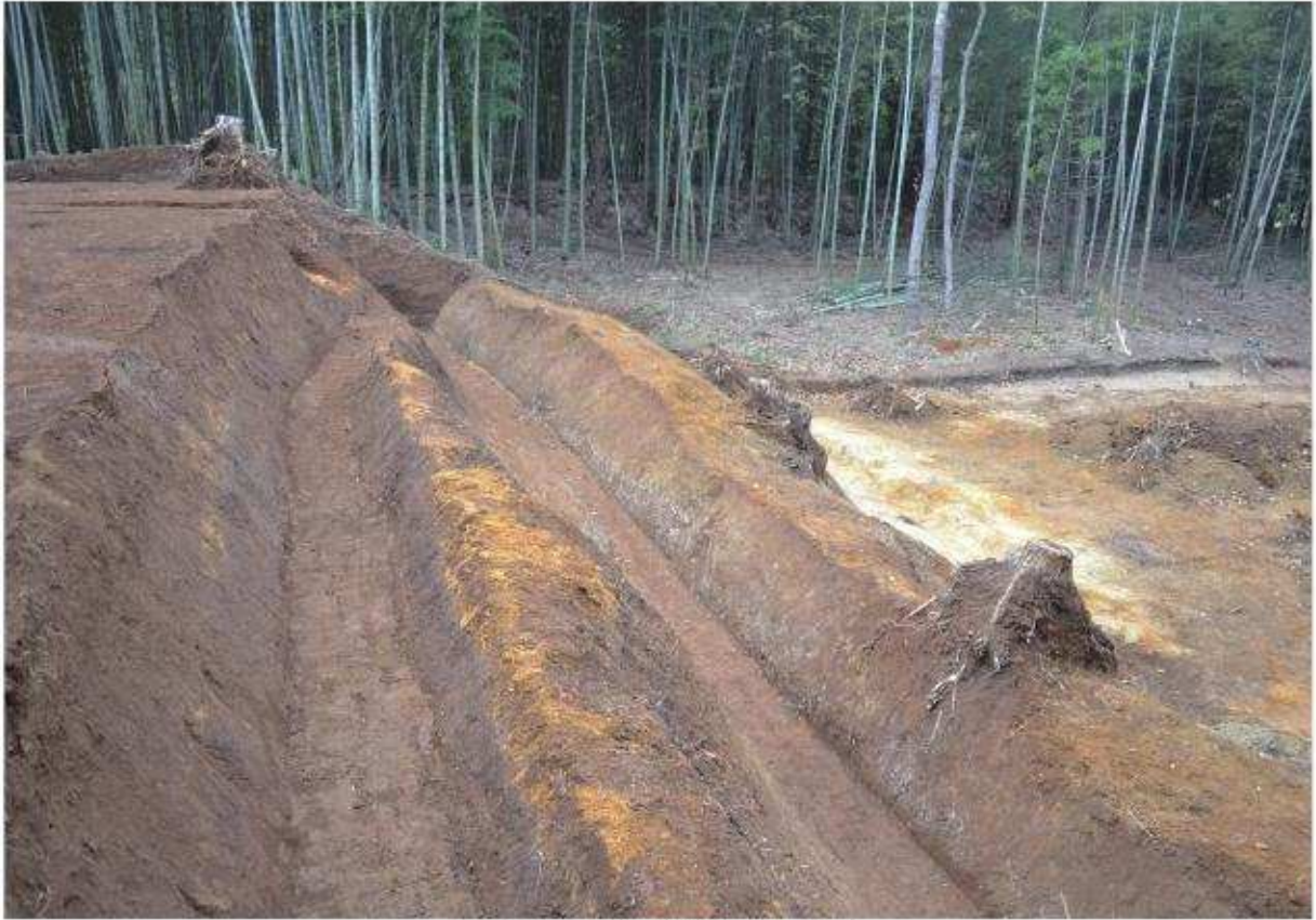
SD-01・02 完掘状況 (北から)
