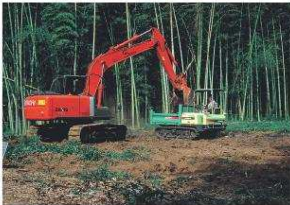
重機による表土除去
