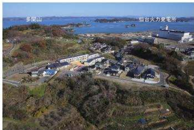
② 調査区現況（南西から）
