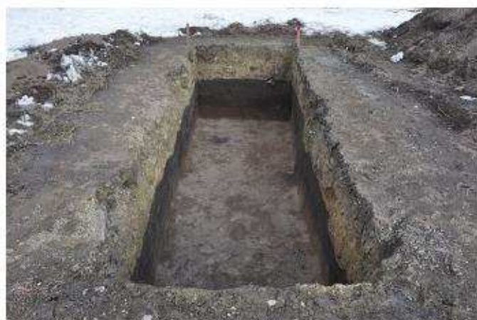
⑥ 20トレンチ全景（西から）
