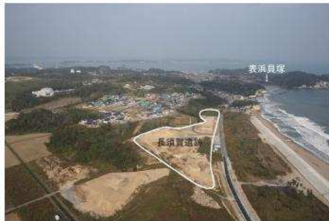
② 調査区現況（南西から）
