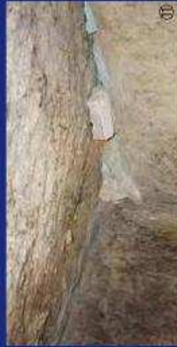
壁石の転倒の原因となっていた壁石と天井石の隙間には、埋め石を行いました⑪。
