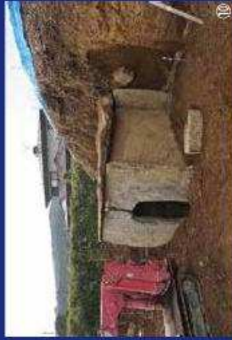
壁石の転倒の原因となっていた壁石と天井石の隙間には、埋め石を行いました⑪。
