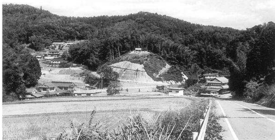
a 遺跡遠景（西から）
