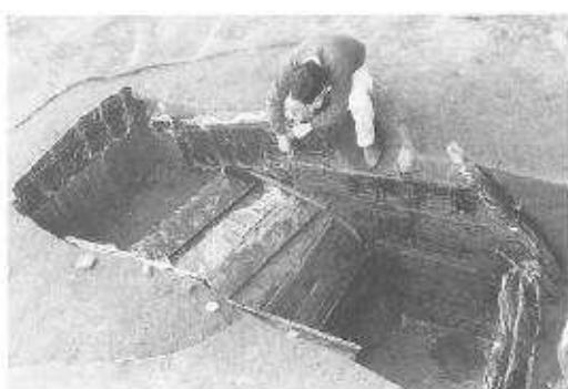
写真3 神戸市住吉宮町遺跡における井戸枠の変形
