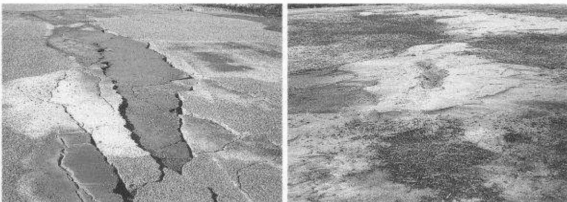
写真1 兵庫県南部地震の液状化現象で生じた地割れ
